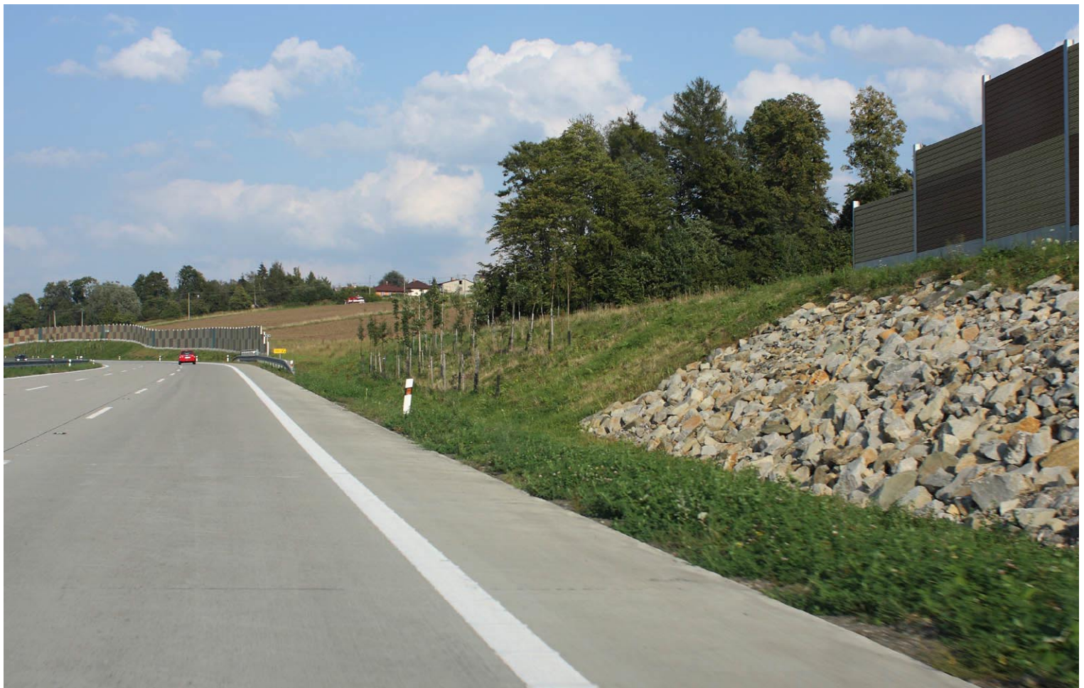
Fot. 9 Morawy: obsadzanie skarp drogowych przy drogach szybkiego ruchu i autostradach; wrzesień 2008
