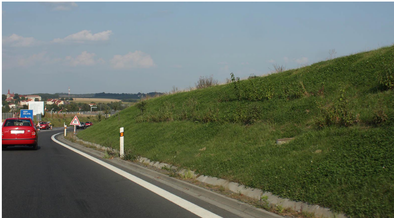
Fot. 15 Morawy: obsadzanie skarp drogowych przy drogach szybkiego ruchu i autostradach; wrzesień 2008
