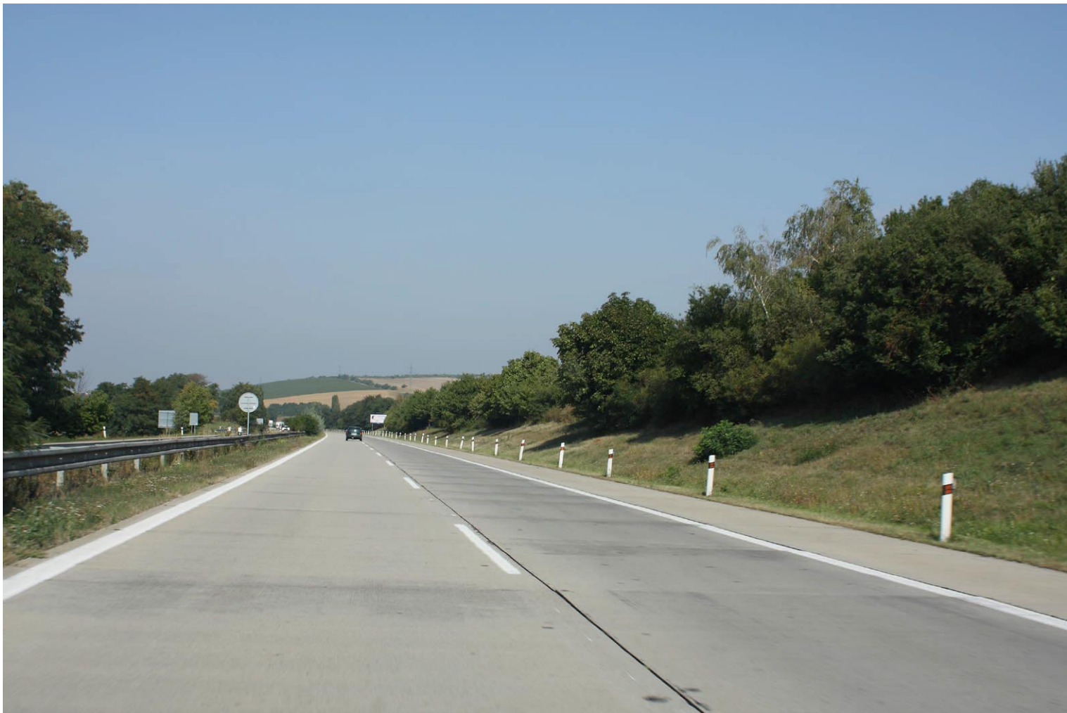
Fot. 7 Morawy: zielen skarp drogowych przy drogach szybkiego ruchu i autostradach; wrzesień 2008
