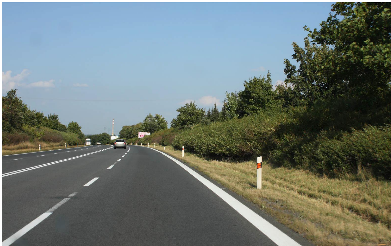
Fot. 6 Morawy: zielen skarp drogowych przy drogach szybkiego ruchu i autostradach; wrzesień 2008
