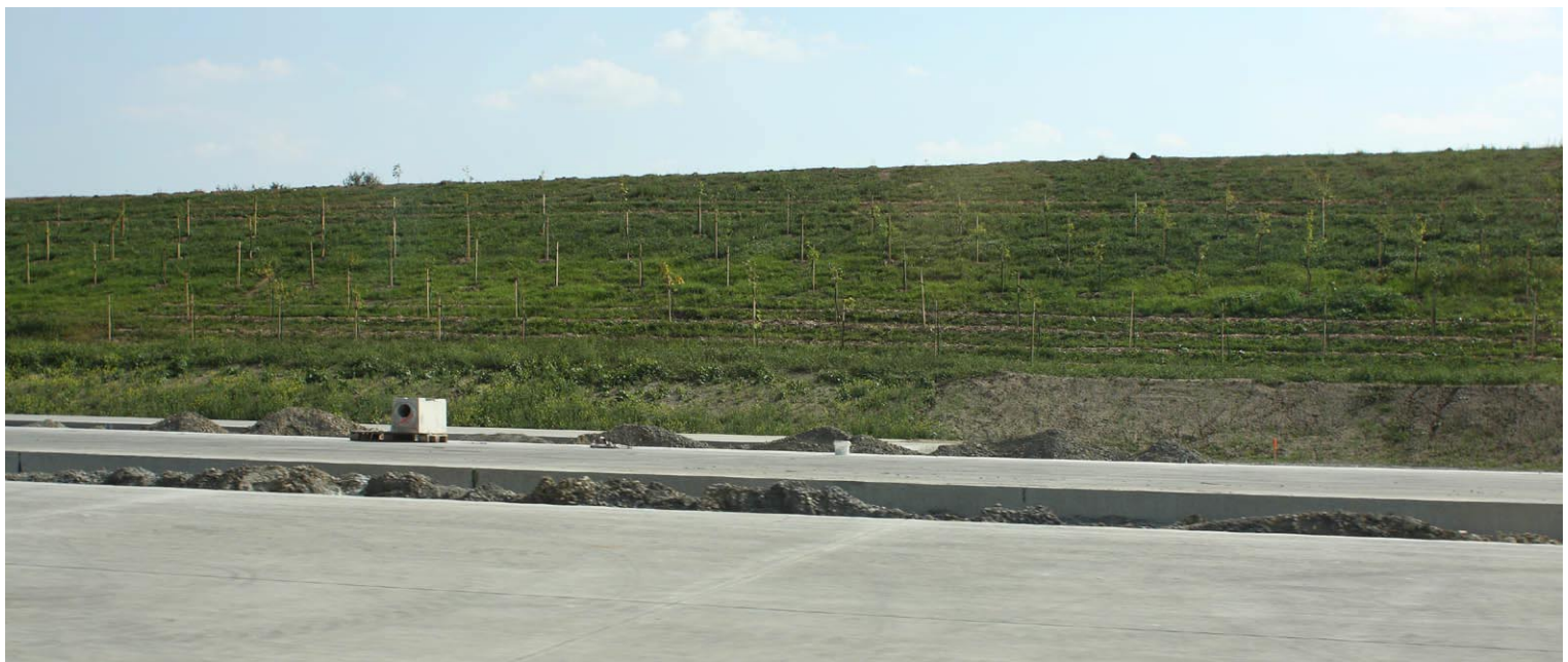
Fot. 8 Morawy: obsadzanie skarp drogowych przy drogach szybkiego ruchu i autostradach; wrzesień 2008
