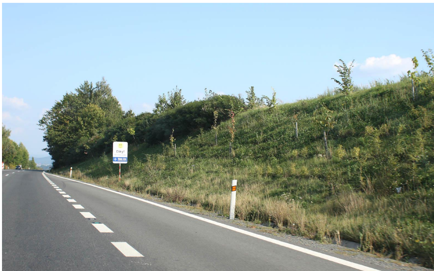
Fot. 4 Morawy: obsadzanie skarp drogowych przy drogach szybkiego ruchu i autostradach; wrzesień 2008
