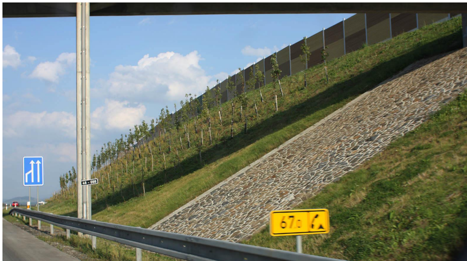
Fot. 2 Morawy: obsadzanie skarp drogowych przy drogach szybkiego ruchu i autostradach; wrzesień 2008
