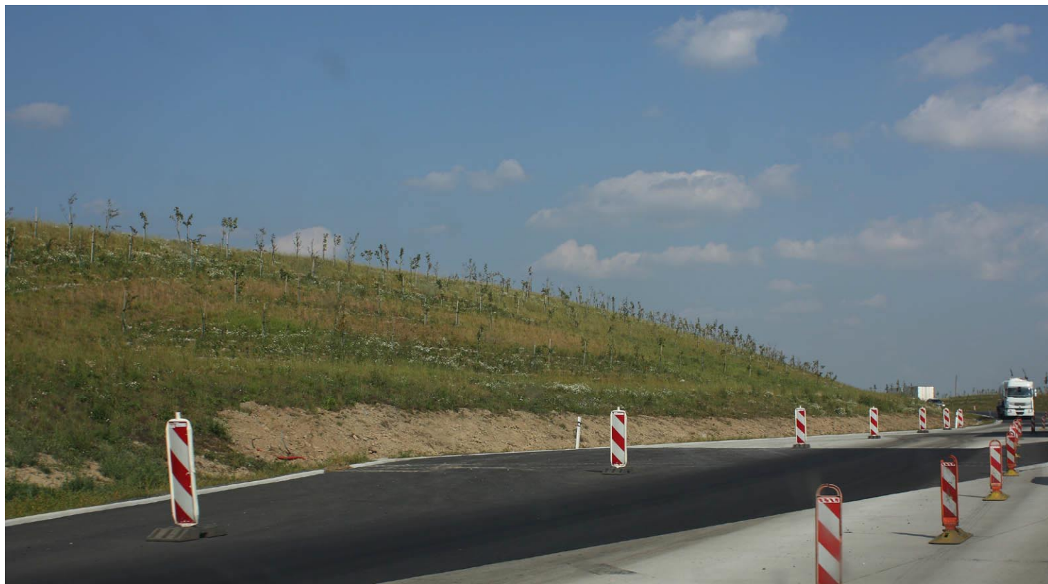
Fot. 5 Morawy: obsadzanie skarp drogowych przy drogach szybkiego ruchu i autostradach; wrzesień 2008
