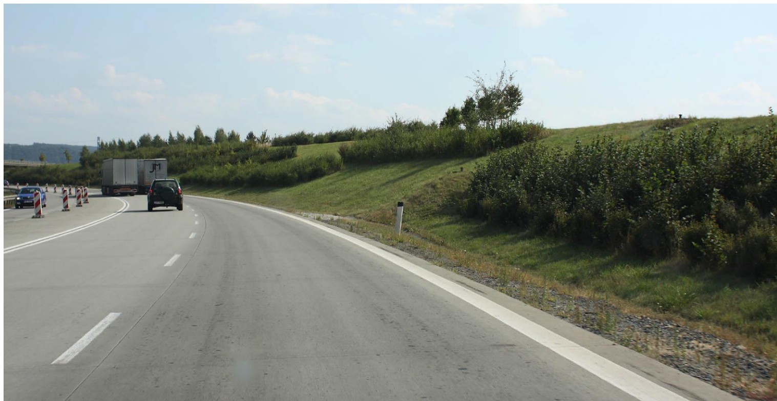
Fot. 3 Morawy: obsadzanie skarp drogowych przy drogach szybkiego ruchu i autostradach; wrzesień 2008
