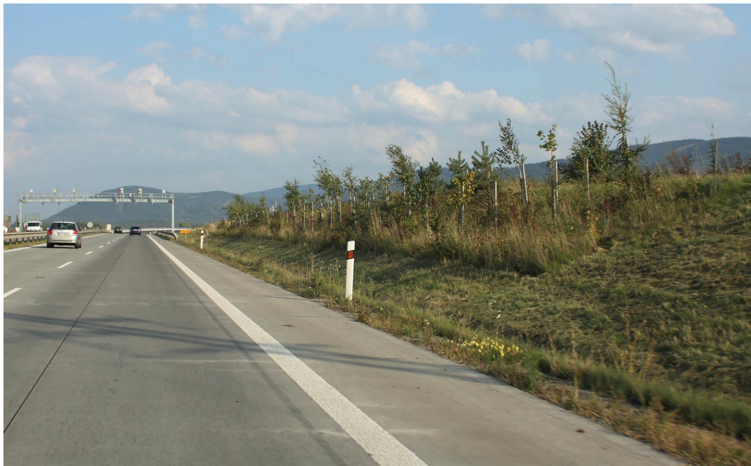
Fot. 1 Morawy: obsadzanie skarp drogowych przy drogach szybkiego ruchu i autostradach; wrzesień 2008
