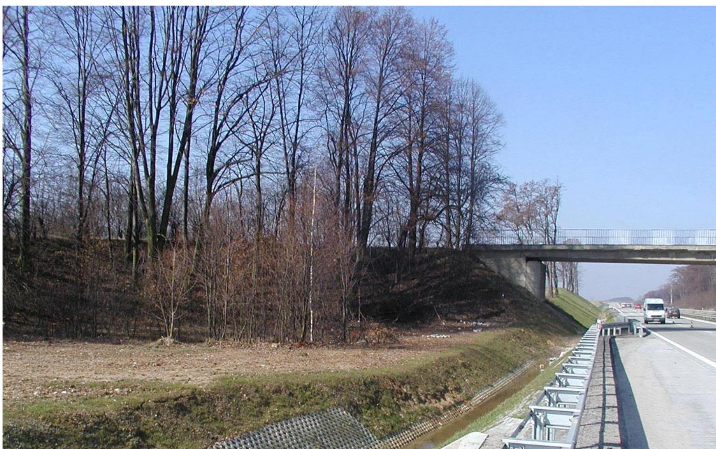
Fot. 12 Zadrzewienia grądowe, ok. 80-letnie, na nasypie drogi poprzecznej. Autostrada A-4 na odcinku Legnica - Kąty Wrocławskie. Marzec 2005.
