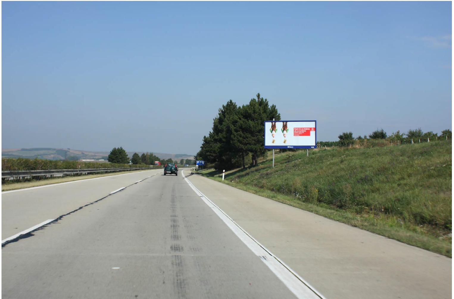
Fot. 10 Morawy: zielen skarp drogowych przy drogach szybkiego ruchu i autostradach; wrzesień 2008
