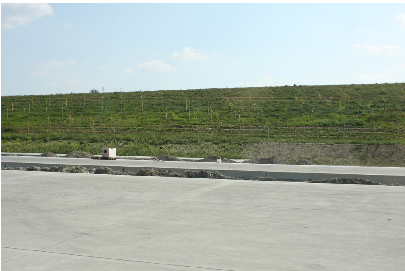
Fot. 10 Nowe nasadzenia przydrożne wykonywane w trakcie budowy autostrady. Sadzenie drzew i krzewów w naorane w murawie pasy. Morawy (Republika Czeska), wrzesień 2008
